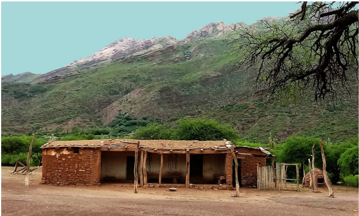
Construcción tradicional en la Laguna Brealito - Andrea Cerletti
