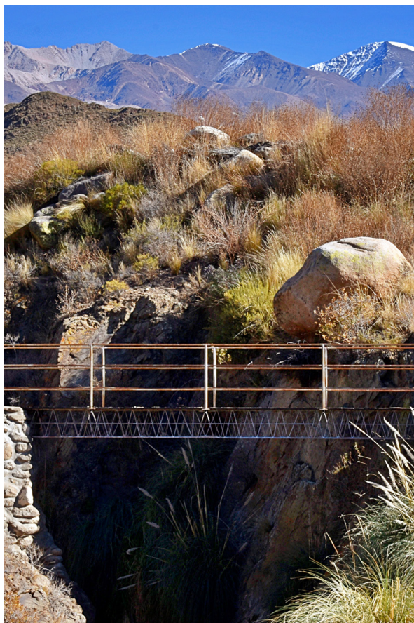
Puente peatonal sobre Río Las Pailas- Anilu Lavín
