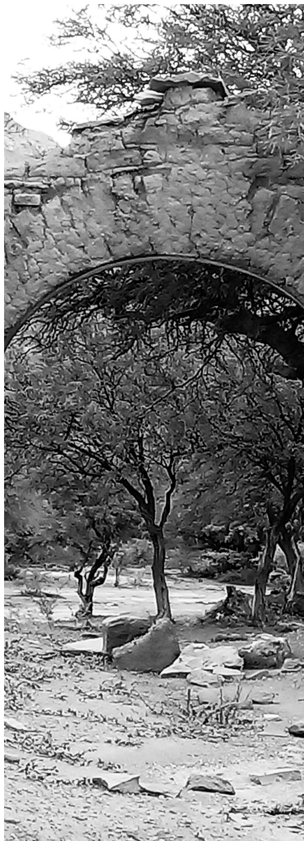
Construcción antigua abandonada. Laguna Brealito Andrea Cerletti
